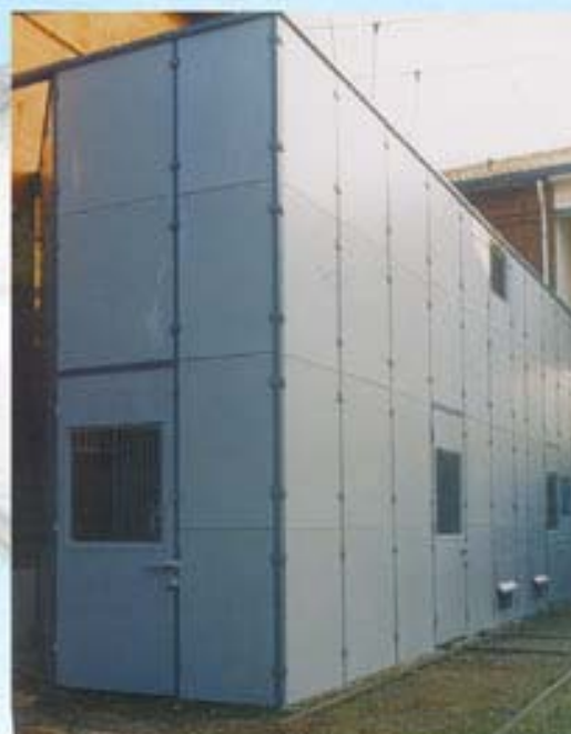
BARRIERA ACUSTICA PER TRASFORMATORI
